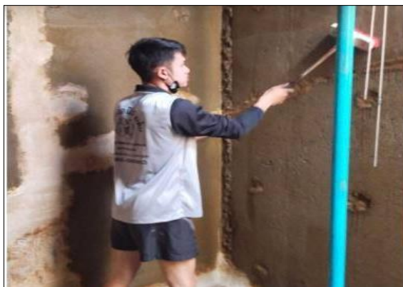
ภาพที่ 2-6 แสดงการล้างถังเก็บน้ำดีประจำปี
